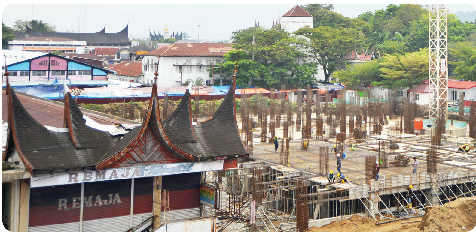
PEMBANGUNAN PASAR RAYA PADANG SENILAI RP 103 M
